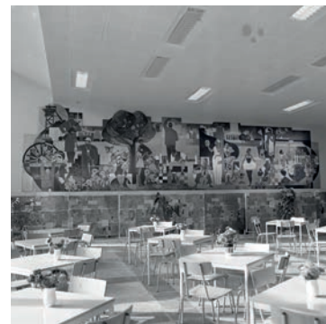
Blick in den Speisesaal des BB Schmirchau mit Hanf-Wandbild, undat., Foto: Archiv Wismut GmbH
